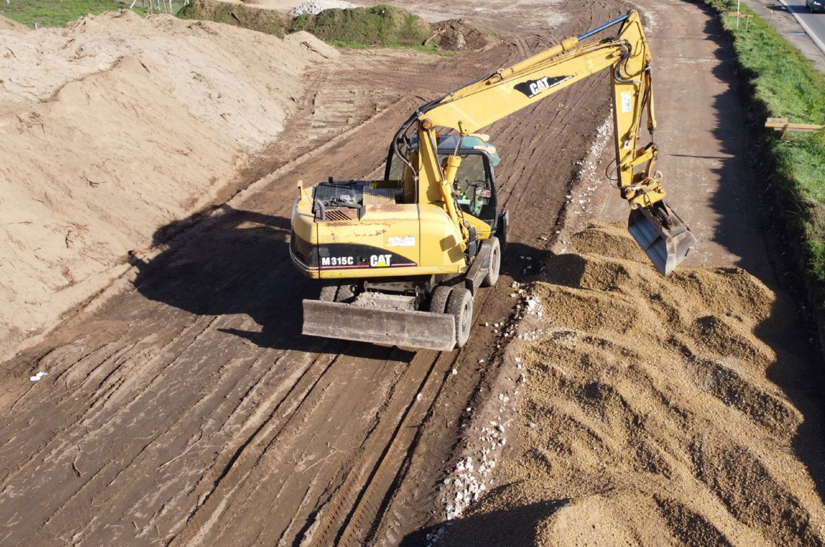
Pohled na strojní úpravu konstrukční vrstvy štěrkodrti o/32.
