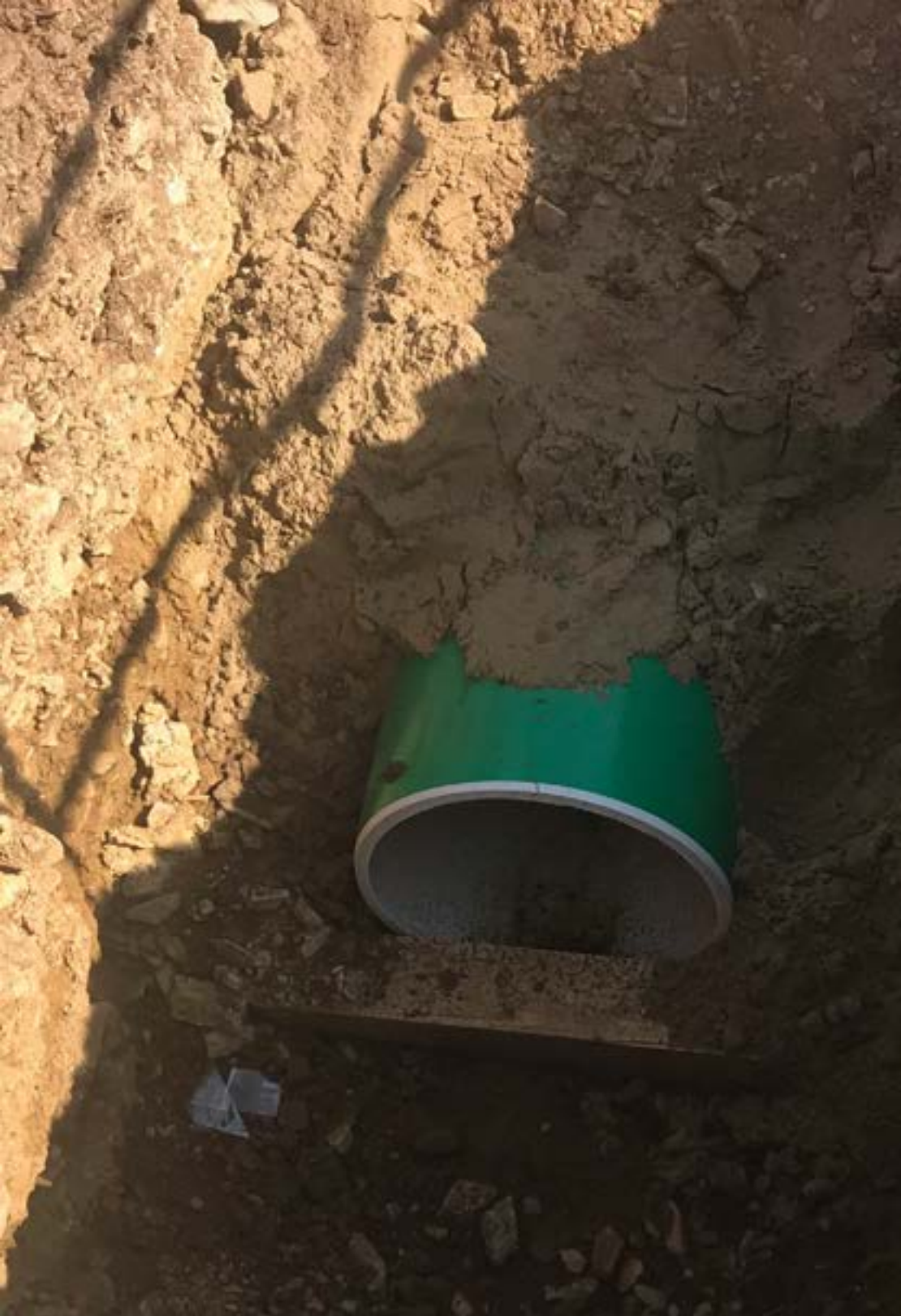
Pokládka kanalizačního potrubí z hladkého PVC
