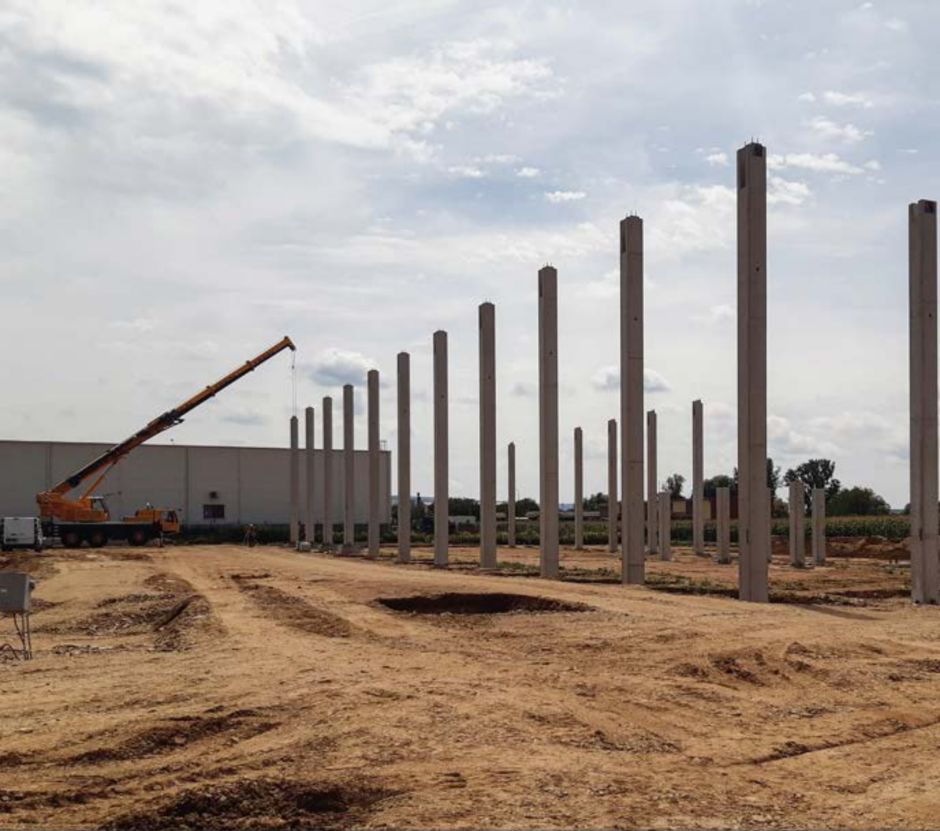
Po dokončení základových konstrukcí a osazení prefa kalichů byla zahájena montáž železobetonových sloupů skeletu
