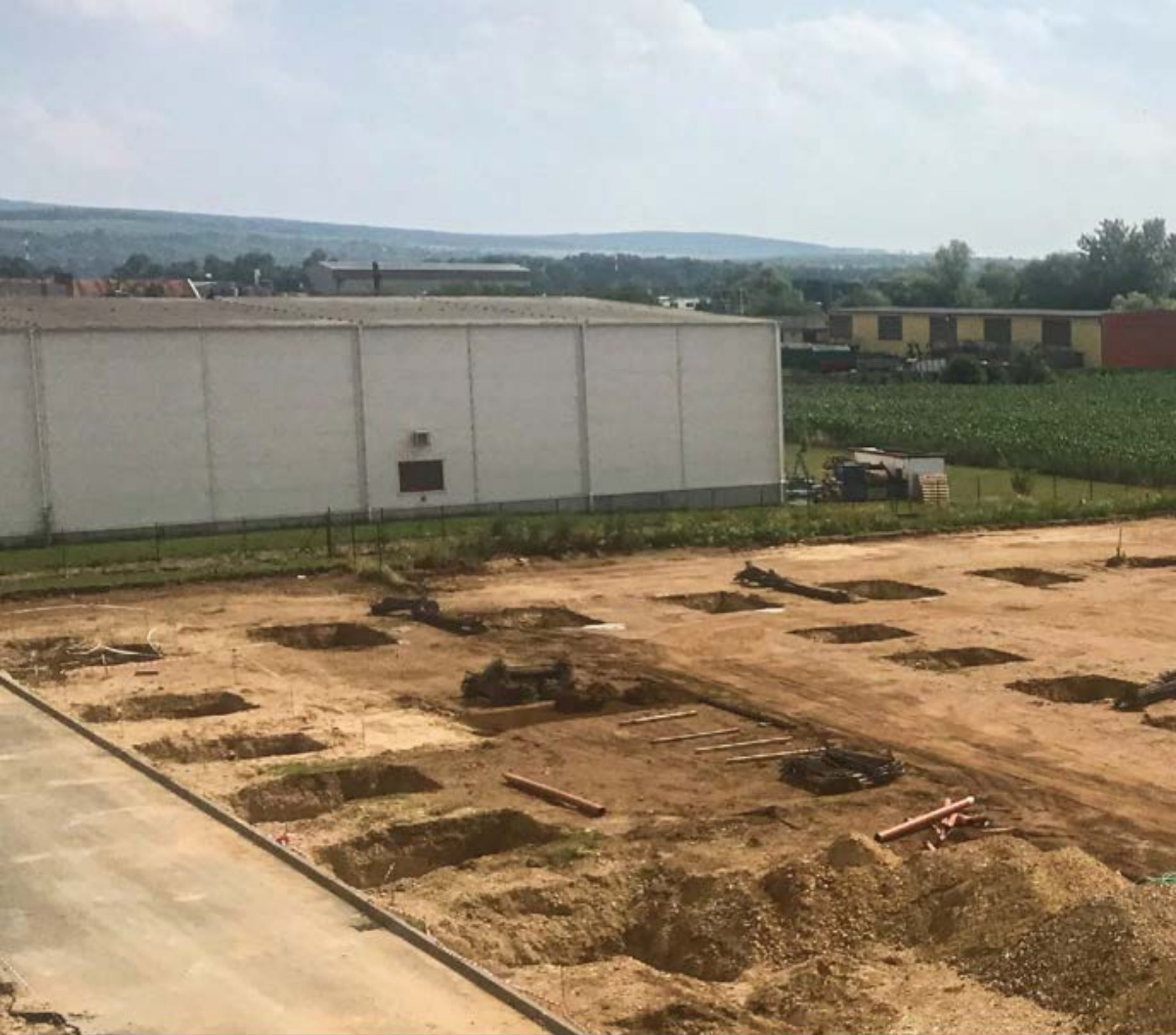
Po sejmutí ornice byly zahájeny výkopové práce pro betonáž základových patek
