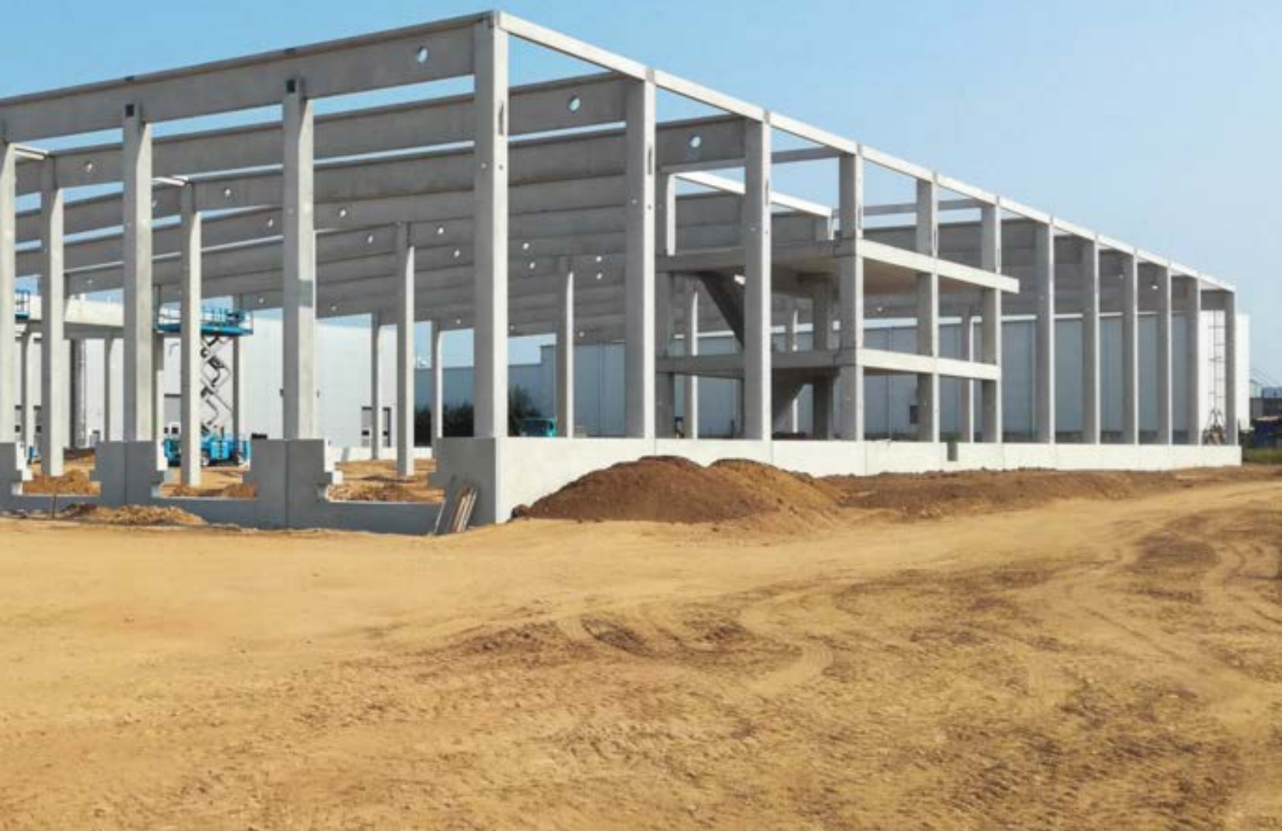
Prefa skelet a základové prahy po dokončené montáži
