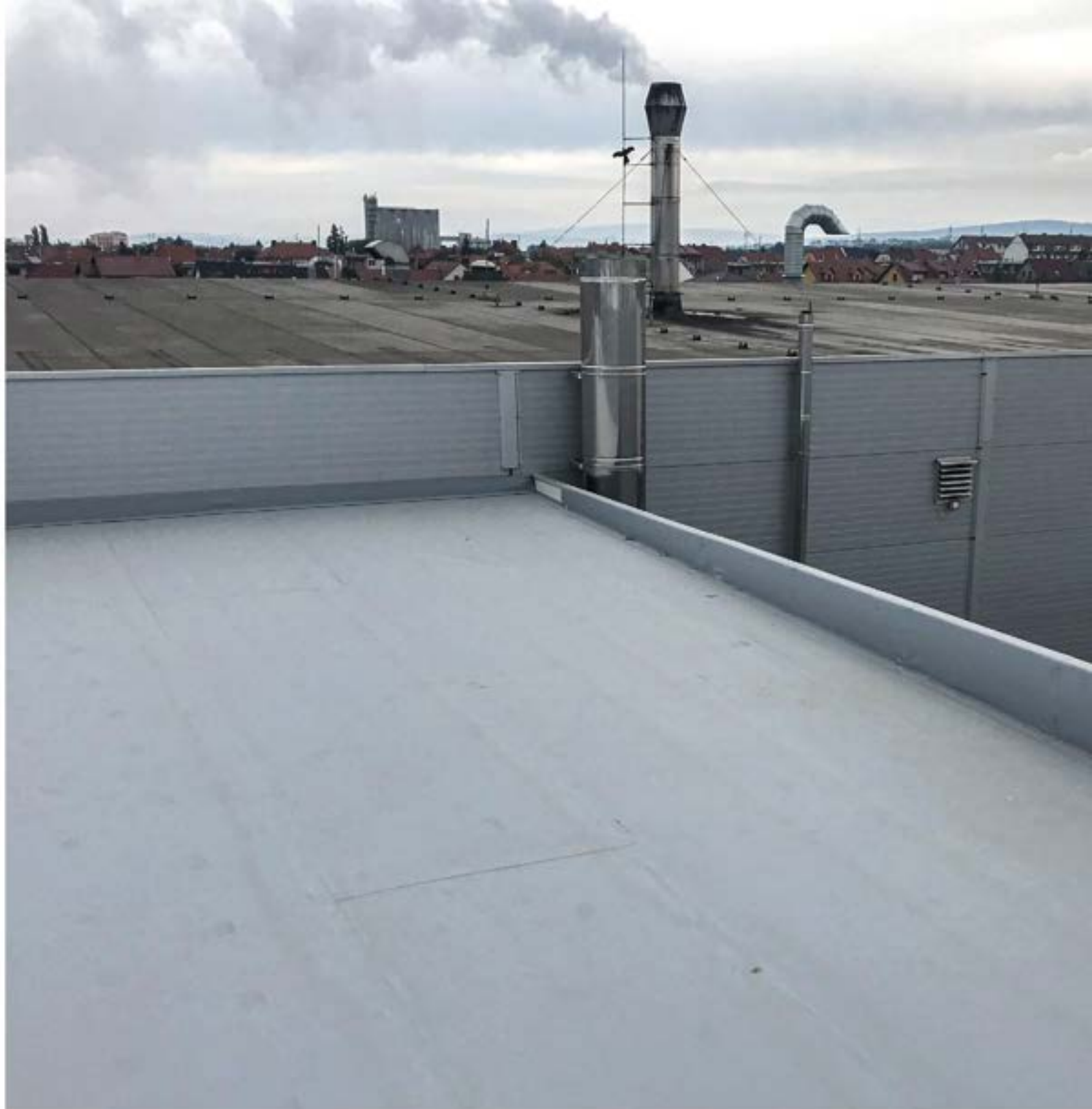
Pohled na část stávajícího objektu a nové přístavby s realizovanou střešní folií
