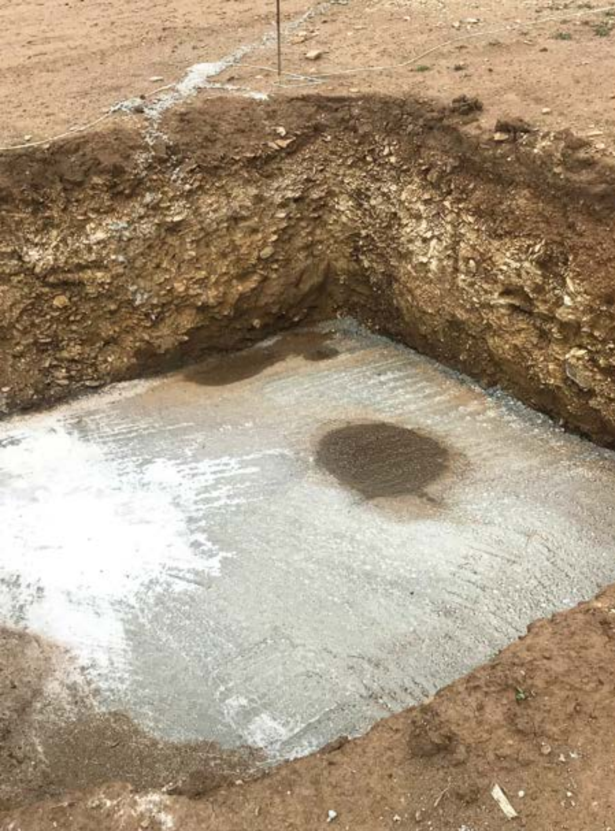
Armování a betonáž základových konstrukcí
