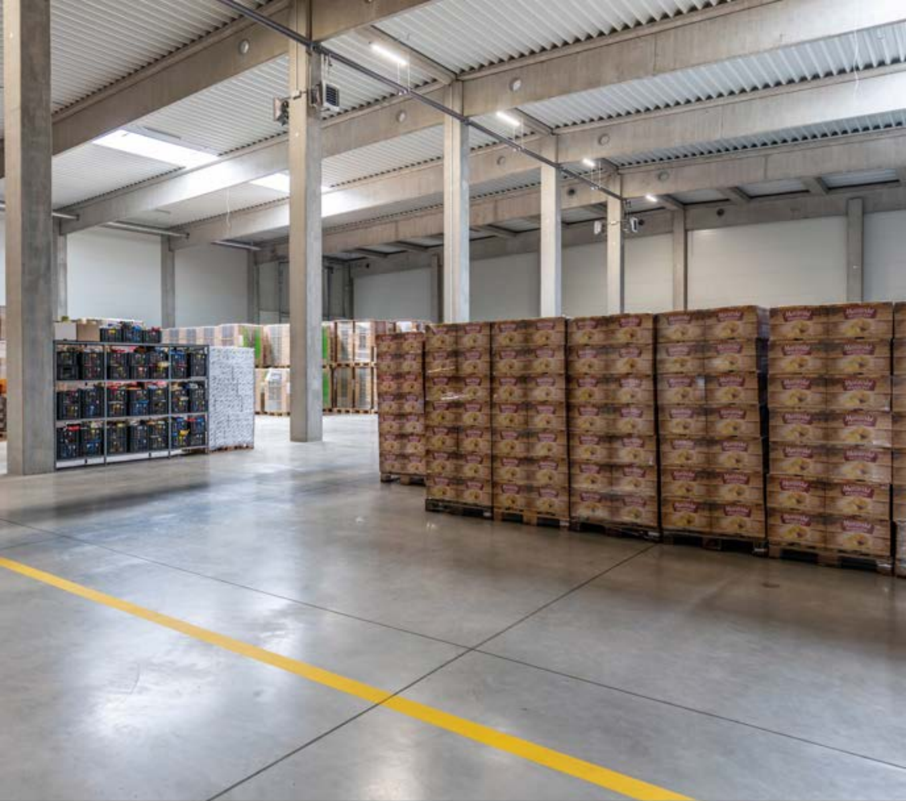
Skladová hala s odolnou průmyslovou drátkobetonovou podlahou
