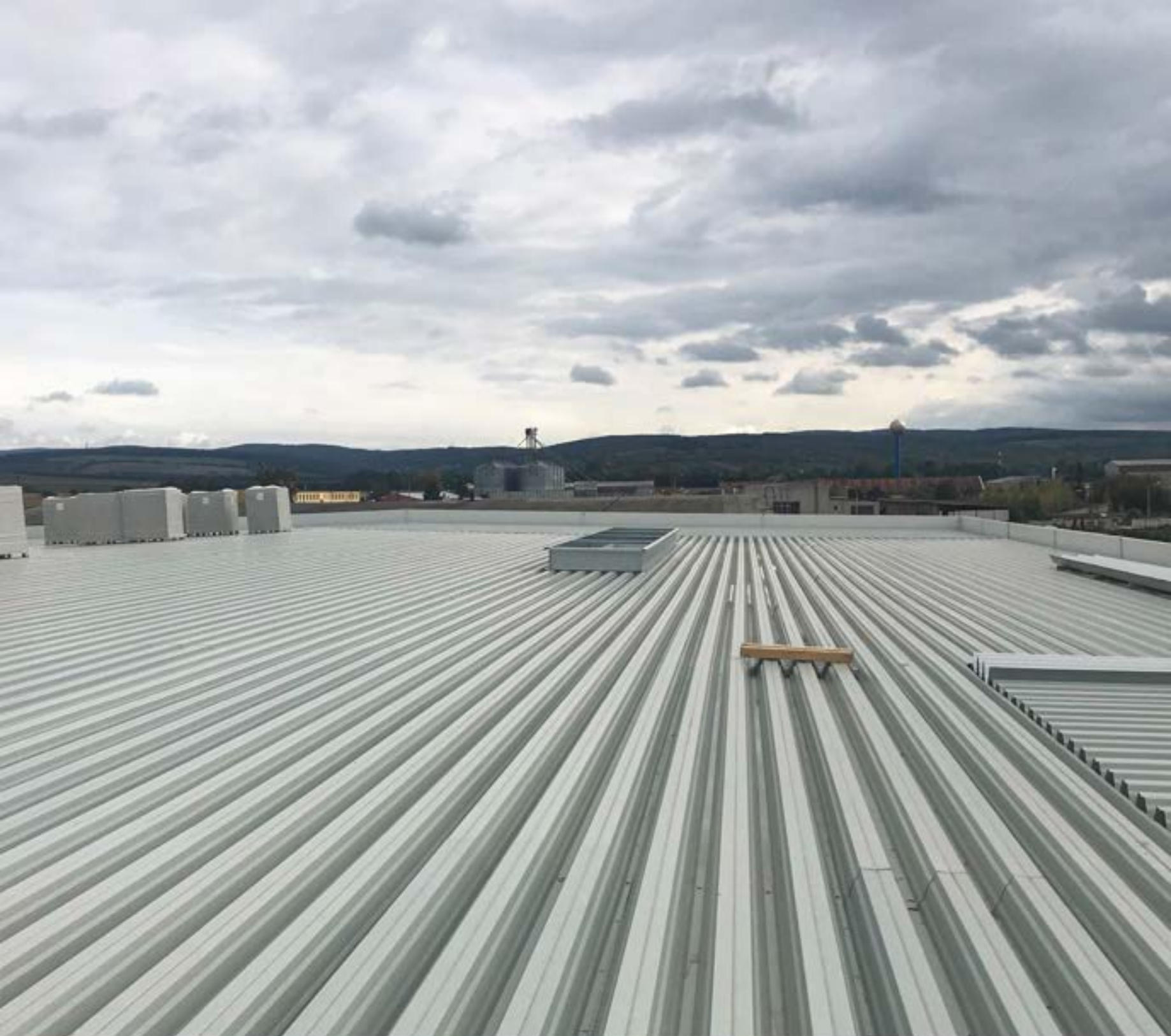
Osazený střešní trapézový plech připravený pro montáž střešního souvrství. Na horizontu je vidět silueta Bílých Karpat
