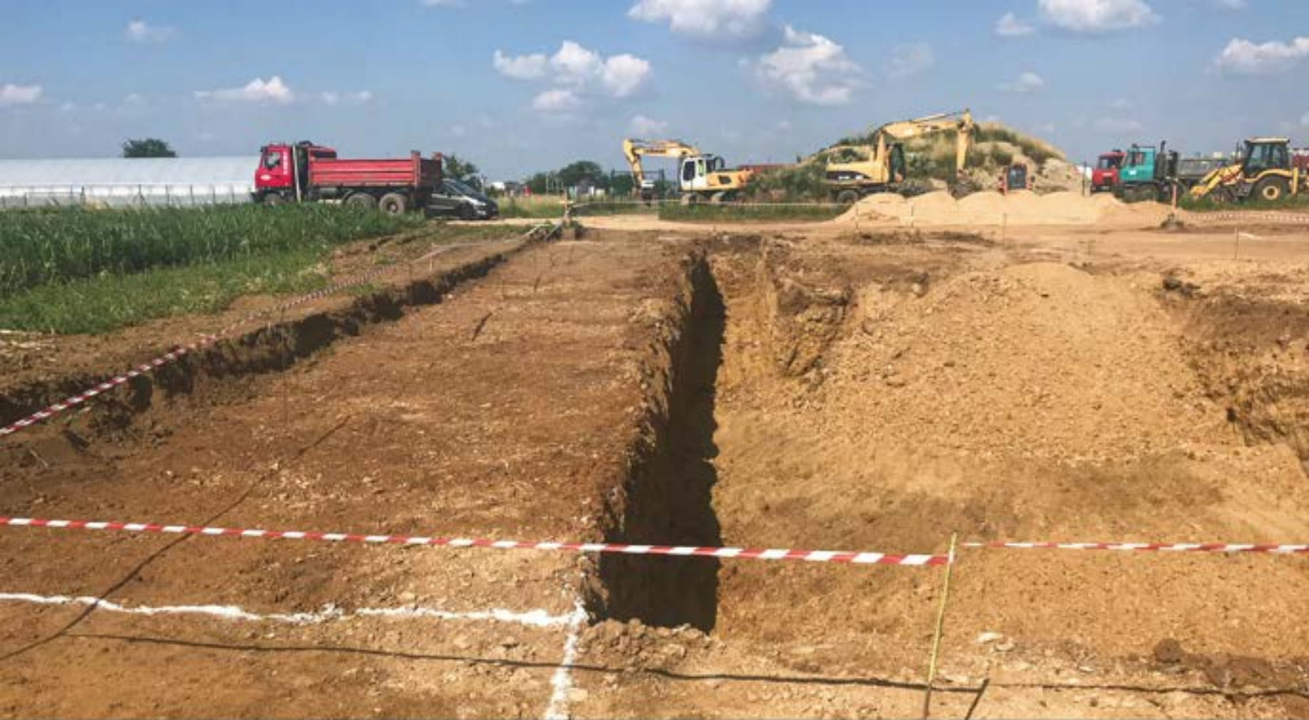
Zahájení výkopových prací s použitím těžké techniky
