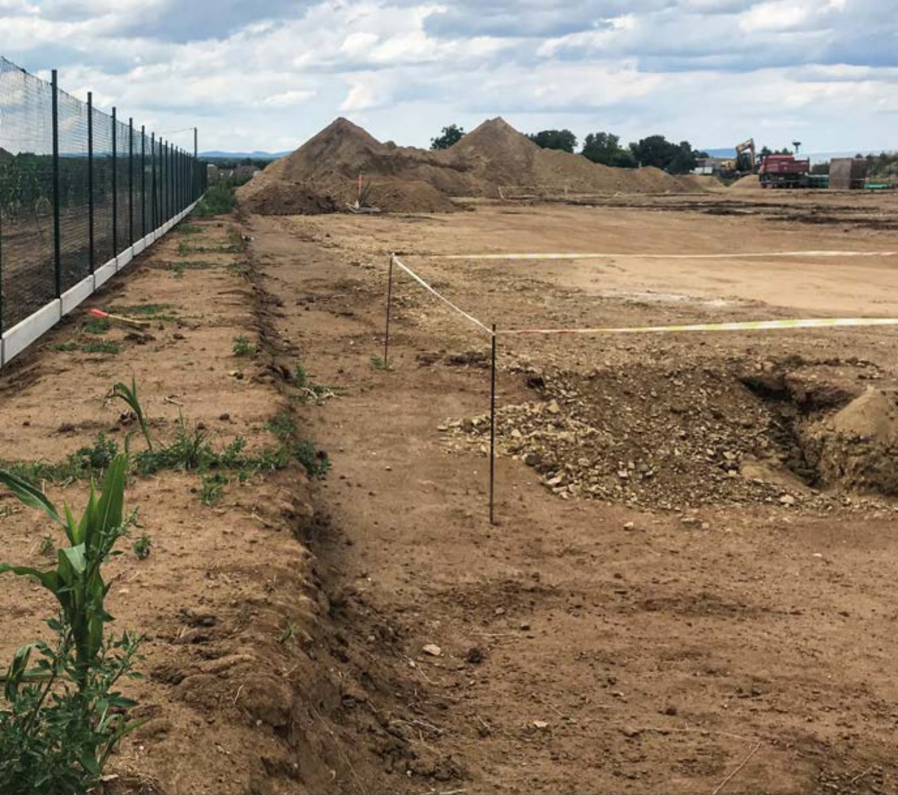
Před zahájením výkopových prací byl celý objekt uzavřen novým poplastovaným oplocením s podhrabovými deskami
