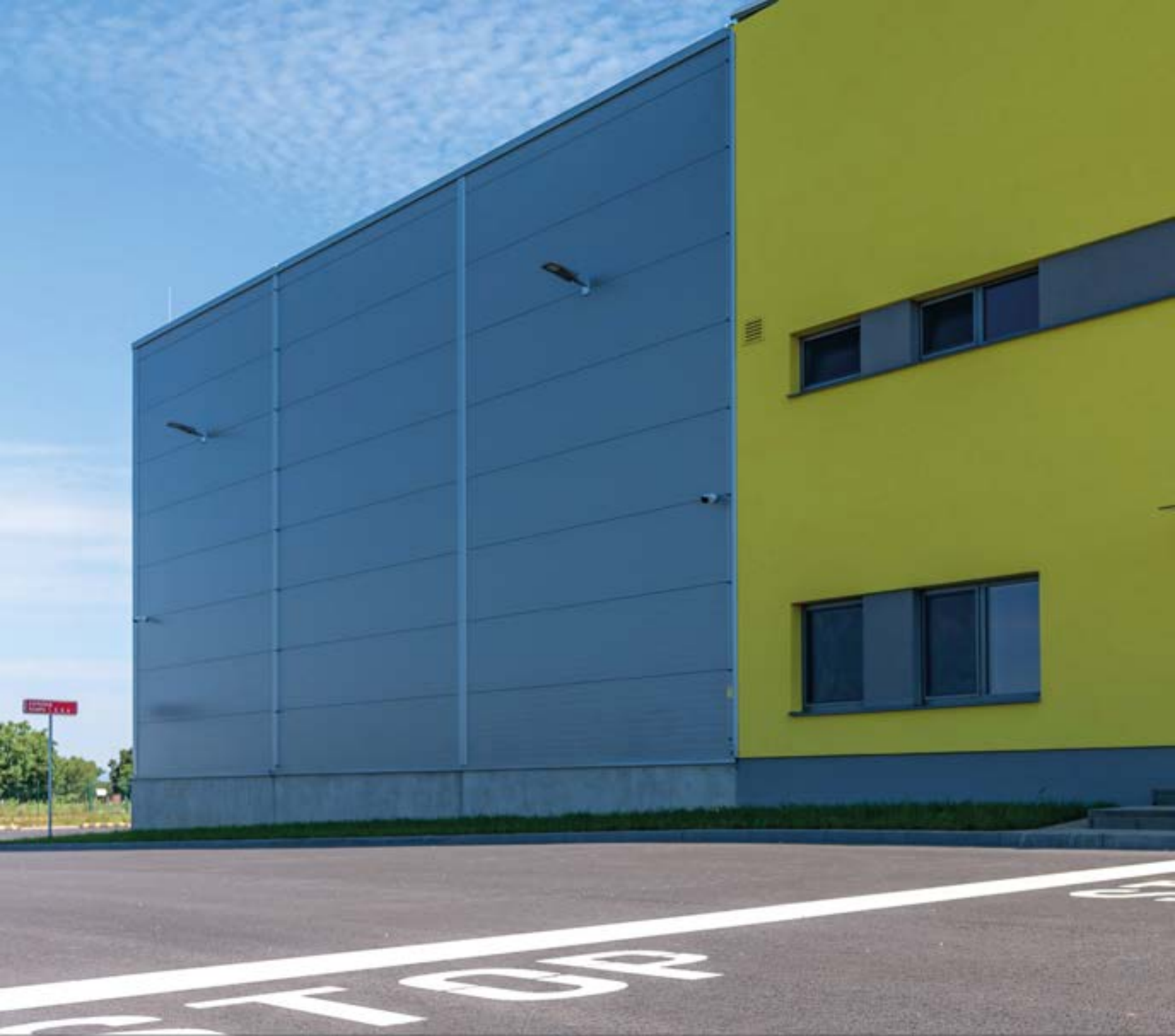
Opláštění administrativního objektu je řešeno klasickou zděnou konstrukcí s výrazným barevným odlišením od výrobní části
