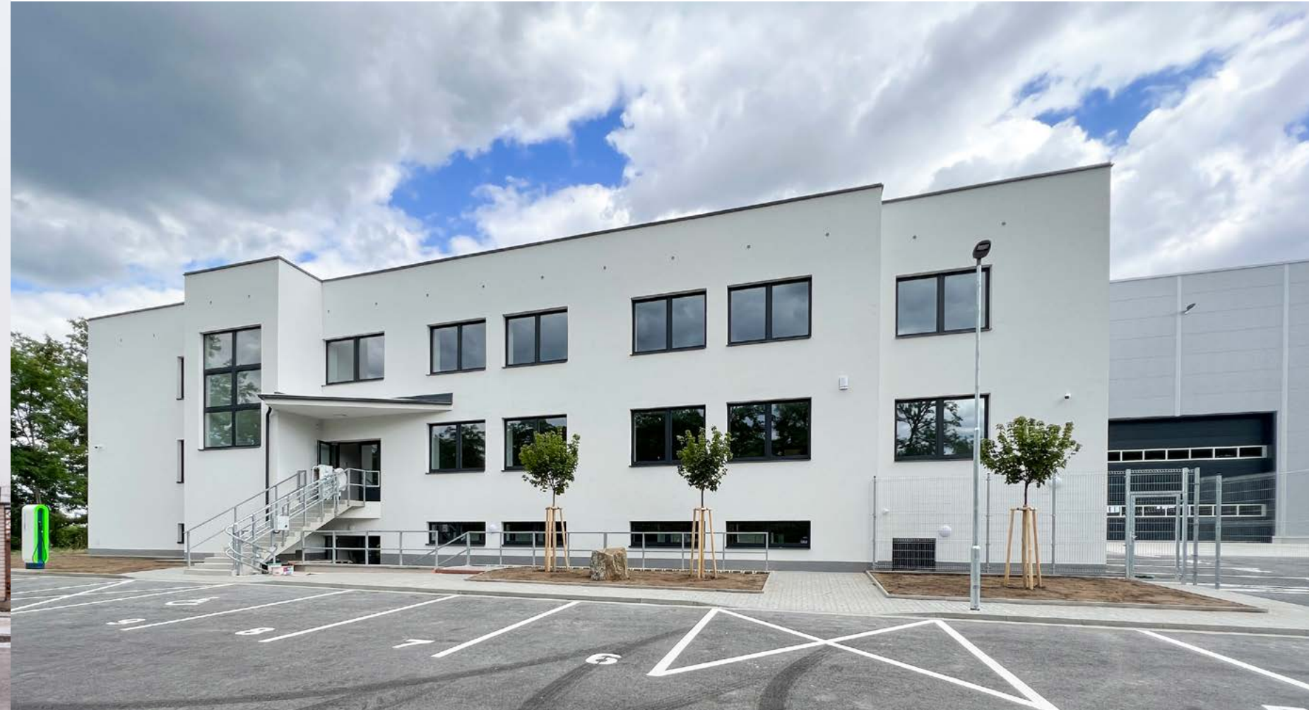
Administrativní budova po dokončení stavebních prací
